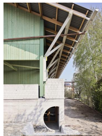
Mehrfamilienhaus «Altes Weinlager», Nuglar
